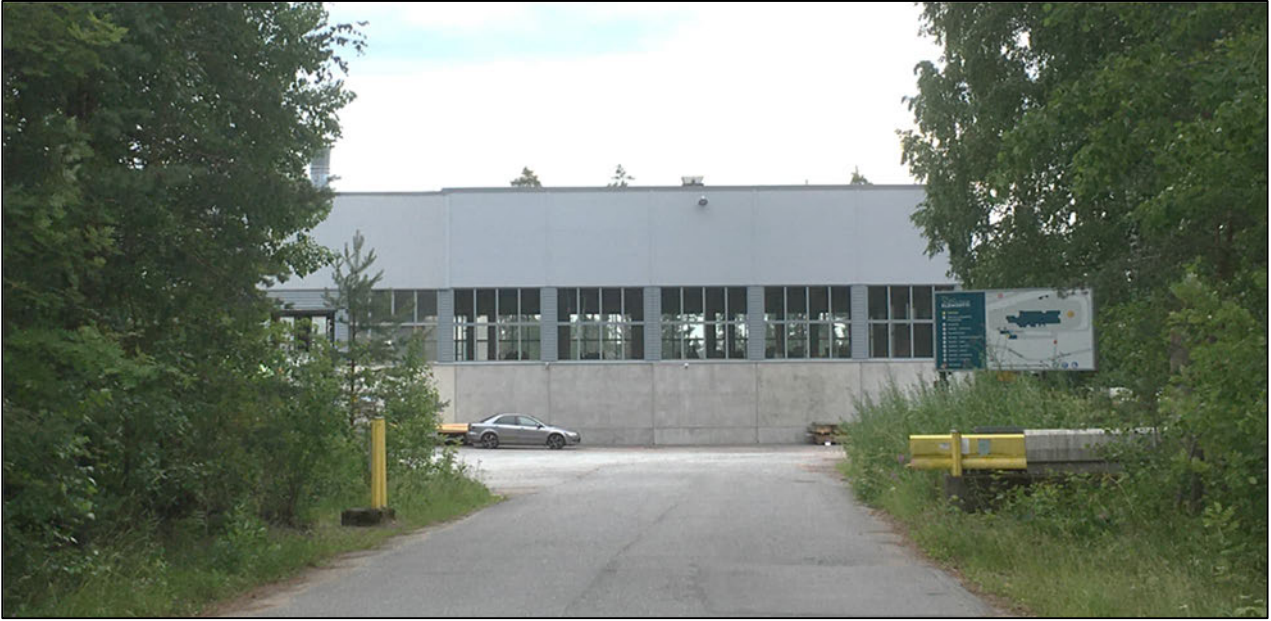
Kuva 5. Sisäänkäynti tehdasalueelle. Tehdashallin betonisokkelin päällä on harmaa betonielementti. Ikkunarivin yläpuolella on vaalean harmaa pellitys.
