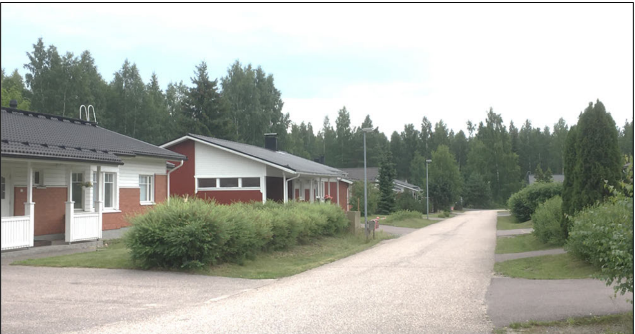
Kuva 8. Näkymä Neulastielle. Yksikerroksissa punatiilivuoratuissa omakotitaloissa on käytetty valkoista vaa-kalauoitusta tehosteena. Tontit on rajattu kadusta pensasaidoin.
