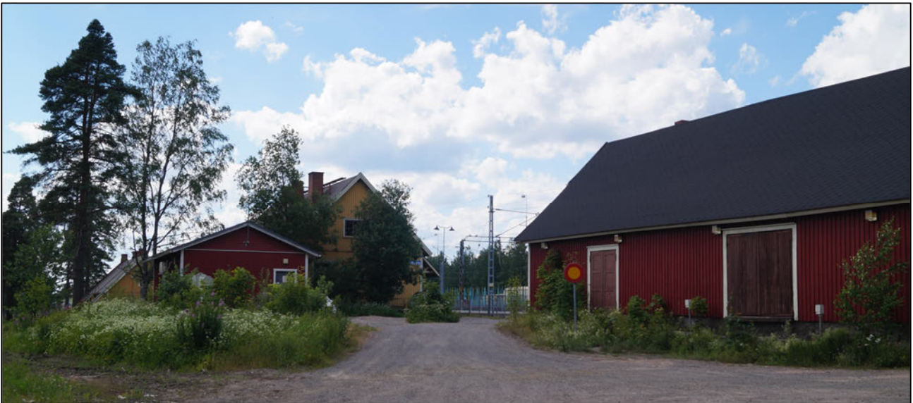
Kuva 4. Joutsenon aseman rakennuksia. Etualalla punamultaisia talousrakennuksia ja taustalla asemarakennus.
